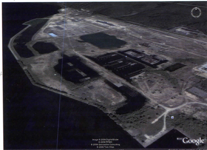
Rys. 30. Rejon głównych obiektów byłej elektrowni jądrowej „Żarnowiec” w budowie
